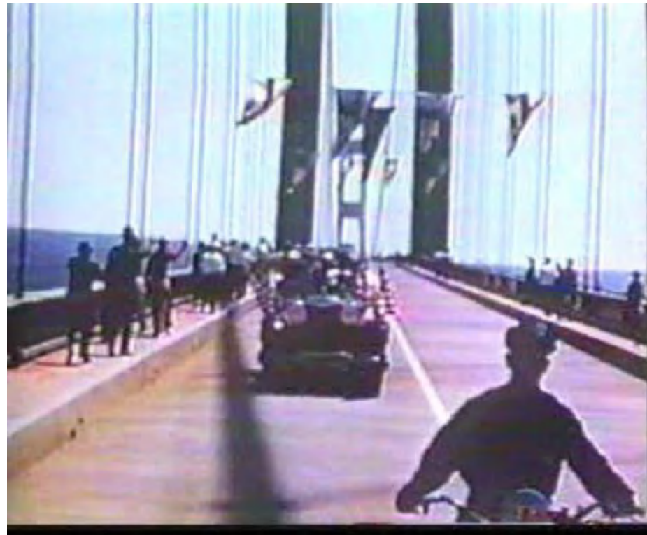
アメリカ タコマの橋の崩落
